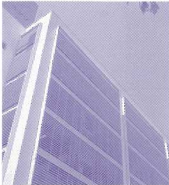
外装ルーバー タワースクリーン
